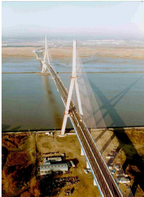
Pont de Normandie, pont à haubans d'une longueur totale de 2141 m, avec une portée centrale de 856 m (1989-1995)
