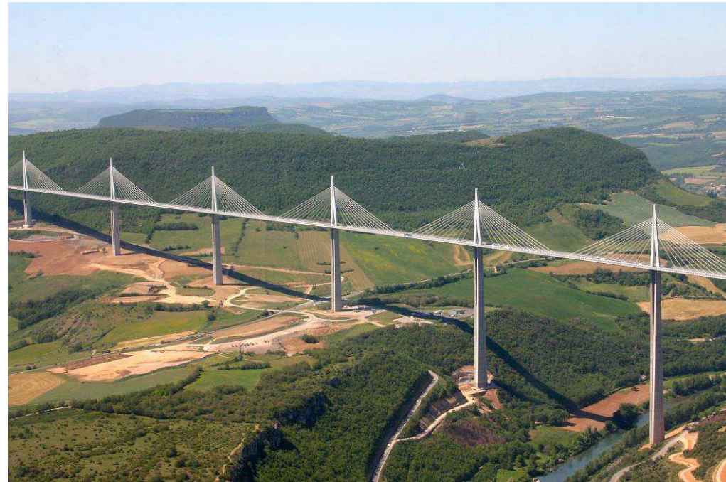
Viaduc de Millau, pont à haubans d'une longueur totale de 2460 m, avec des portées de 204 m et 342 m (2001-2004)
